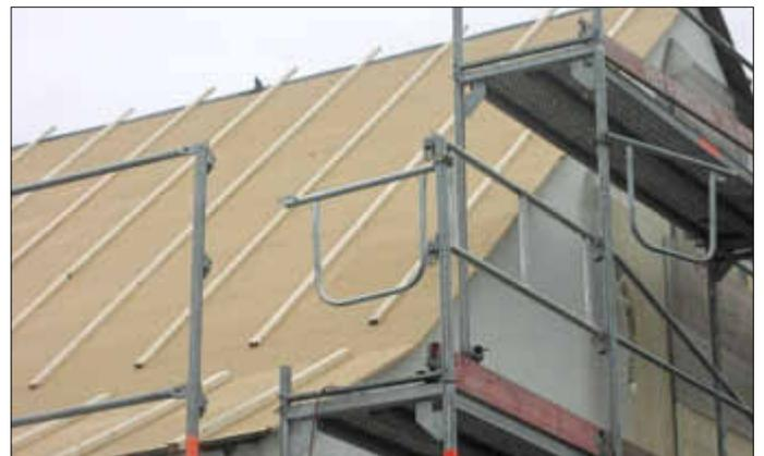
*Holzweichfaserplatte als äußerer Abschluss für die Dachdämmung.
