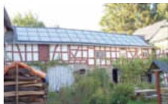
*Eine Solaranlage für Warmwasser- und Heizungsunterstützung ist nicht für jeden Haushalt und jedes Dach geeignet. Bei diesem Fachwerkbau, der zusätzlich mit Holz geheizt wird, hat sich die Investition gelohnt. Foto: VZRLP/H. Kitzerow*
