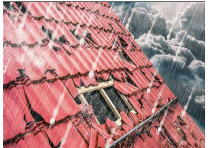
Die immer häufiger auftretenden Unwetter lassen nicht selten Schäden am Dach zurück. In dem Fall können jene Bewohner aufatmen, die sich bei der Errichtung des Hauses für hochwertige Unterdeckbahnen entschieden haben. Diese sind als zweite Funktionsebene unter der ersten, sprich den Dachziegeln, Dachsteinen und Co, befestigt und übernehmen zuverlässig und sicher deren Aufgabe – also zu verhindern, dass beispielsweise Hagel und Regen in die Wärmedämmung beziehungsweise
