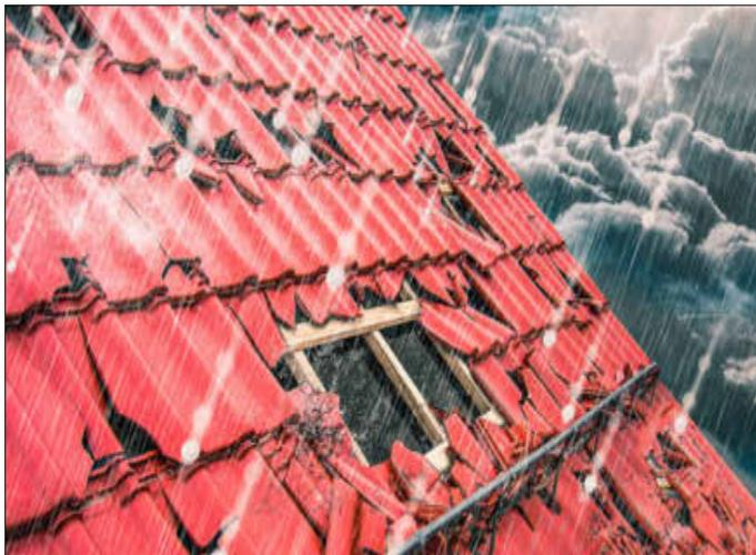
Die immer häufiger auftretenden Unwetter lassen nicht selten Schäden am Dach zurück. In dem Fall können jene Bewohner aufatmen, die sich bei der Errichtung des Hauses für hochwertige Unterdeckbahnen entschieden haben. Diese sind als zweite Funktionsebene unter der ersten, sprich den Dachziegeln, Dachsteinen und Co, befestigt und übernehmen zuverlässig und sicher deren Aufgabe – also zu verhindern, dass beispielsweise Hagel und Regen in die Wärmedämmung beziehungsweise
