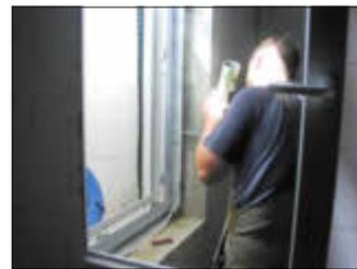
**Montageschaum reicht beim Einbau neuer Fenster nicht aus – der Rahmen muss luftdicht in der Leibung verklebt werden.**
