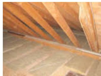
**Holzbalkendecken lassen sich von oben optimal mit Mineralwolle zwischen den Deckenbalken dämmen. Durch die Abdeckung mit OSB-Platten wird der Dachraum wieder begehbar. Bernhard Andre**
