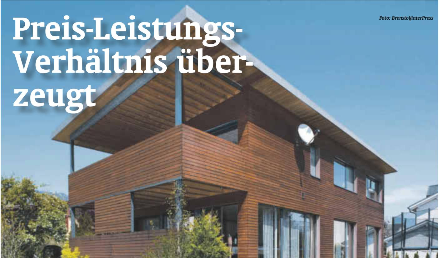
Immer häufiger wird Holz zur Verschönerung der Fassade gewählt, speziell Thermoholz ist dafür prädestiniert. Nicht nur, dass sich mit dem dauerhaften, jenseits von 200 Grad Celsius behandelten Material optisch ansprechende
