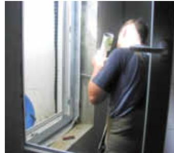
*Montageschaum reicht beim Einbau neuer Fenster nicht aus – der Rahmen muss luftdicht in der Leibung verklebt werden.*
