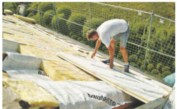
Typische Sanierungssituation: Der ausgebaute Dachstuhl ist nur mit Gipskartonplatten innenseitig verkleidet, die Zwischensparrendämmung ist technisch veraltet. Eine professionelle Dachdämmung ist hier anzuraten, denn die senkt die Heizkosten drastisch.
